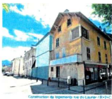
Construction de logements rue du Laurier / R+2+C
